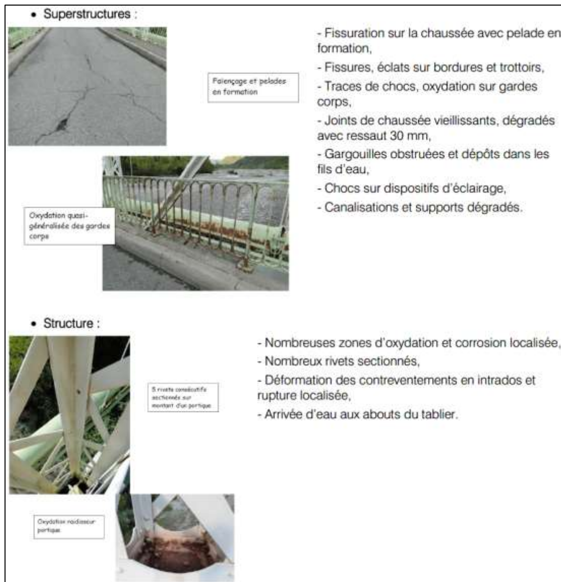
Figure 6 : Illustrations des désordres observés sur le pont existant (SCE, 2019)
