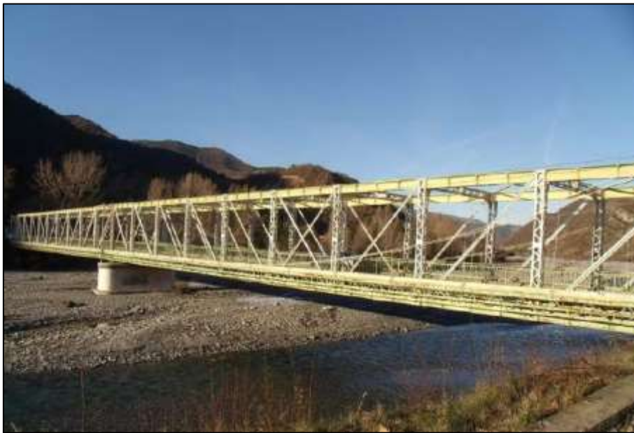
Figure 5 : Élévation aval de l'ouvrage existant (SCE, 2019)
